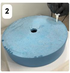
RUN A LINE OF CLEAR BATHROOM SILICONE AROUND THE UNDERSIDE OF THE SINK 1/2" BACK FROM THE EDGE
